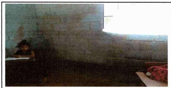
Foto 6: Las paredes se encuentran en mal estado por la humedad del suelo.
