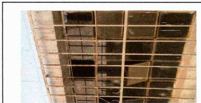
Foto 5: Ventanales se encuentran oxidadas y necesitan mantenimiento o sustitución.
